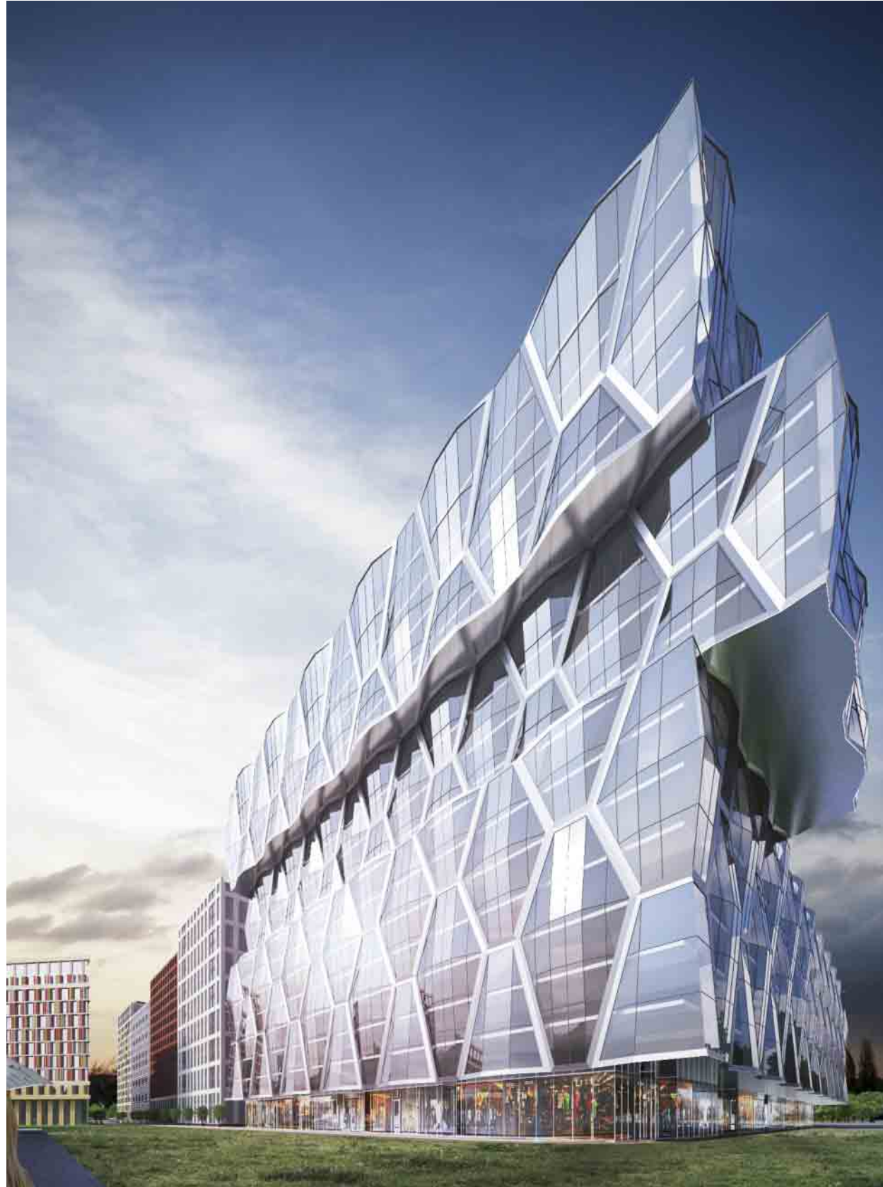
▲ Iskra Park Multifunktionskomplex, Moskau/RU, SPEECH, Moskau/RU. Das Bürogebäude mit einer kristallinen Fassade steht im bewussten Kontrast zu der für das Viertel charakteristischen Architektur. Schüco System: FWS 50 SG. Elementfassade: Sonderlösung auf Basis von UCC
