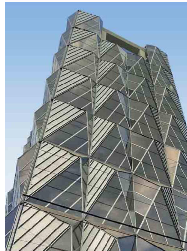
▲ RMK Headquarter, Jekaterinburg/RU Foster + Partners, London/GB Die Fassade für das Headquarter der Russian Copper Company (RMK) ist inspiriert von der kristallinen Struktur der Kupfermoleküle. Schüco Systeme: Sonderkonstruktion Parametric Façade, AOC 50, AD UP 75
