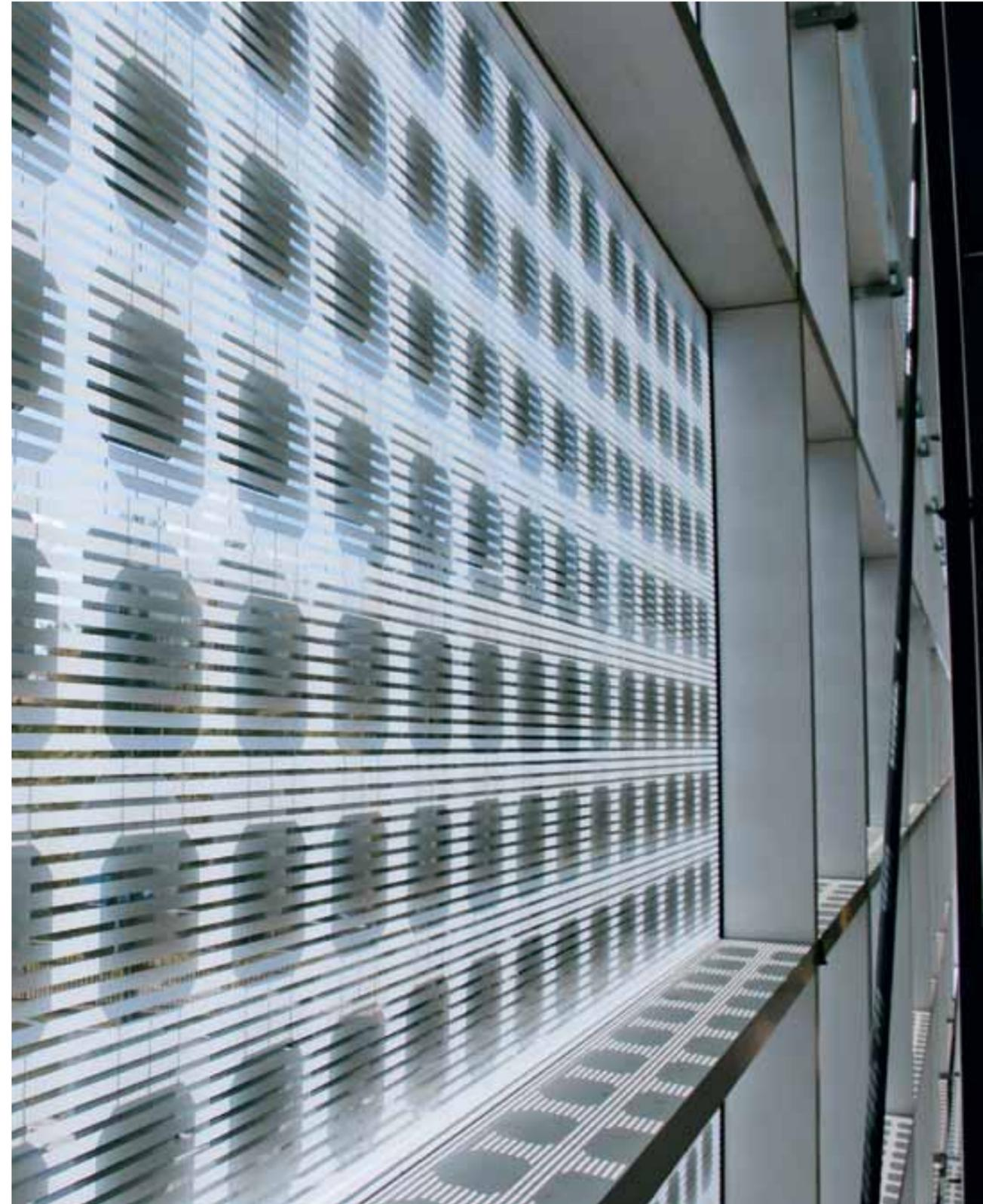
Durch den Einsatz der Photovoltaikmodule können bereits 80% der für Wärmepumpen benötigten elektrischen Energie erzeugt werden
