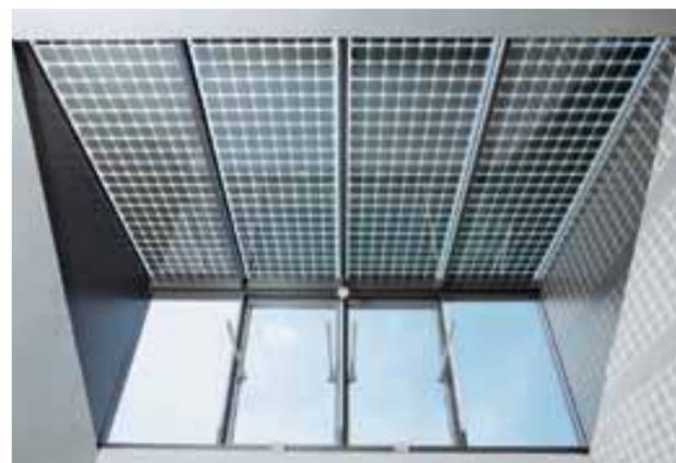
Die Sheddachflächen wurden zusätzlich mit Photovoltaikmodulen bestückt
