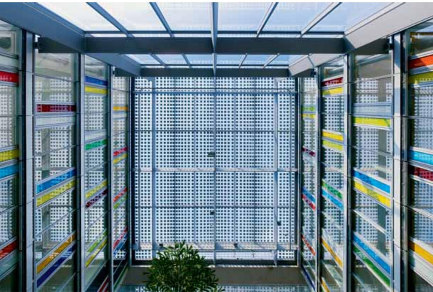
Durch die Photovoltaikzellen, die zwischen die Glasscheiben eingebettet sind, wird etwa eine 50-prozentige Verschattung und ein Gesamtertrag pro Jahr von 7100 Kilowattstunden erreicht
