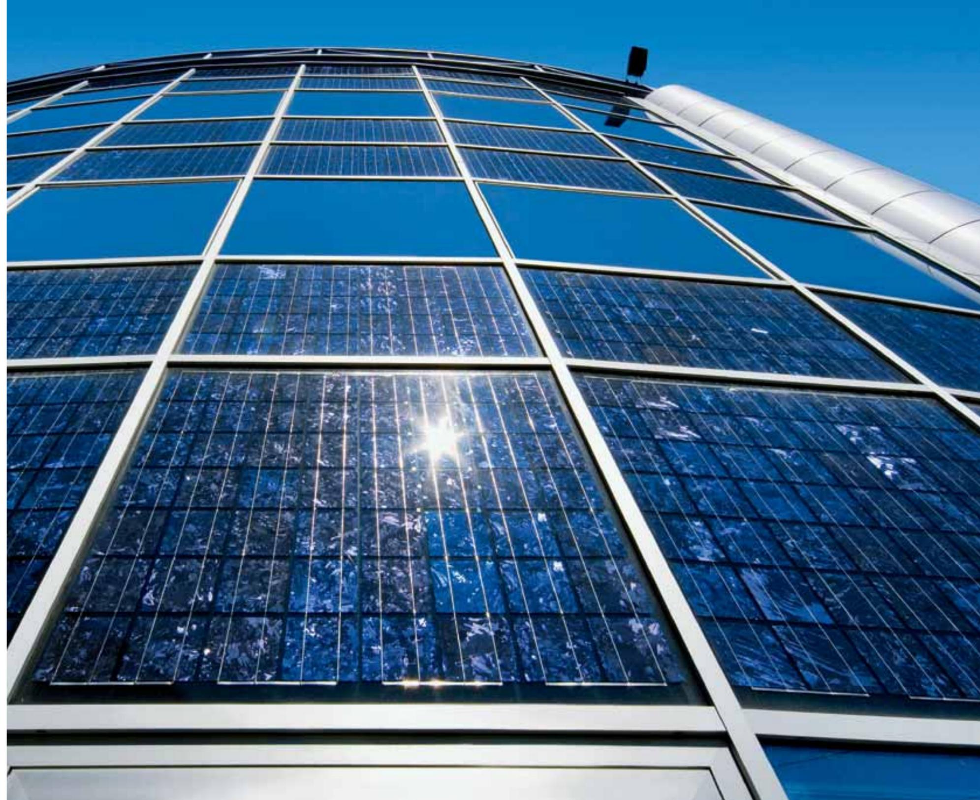
Die Photovoltaikmodule sind flächenbündig in die Fassade integriert
