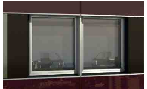
6. Montage der Füllungselemente im Kaltbereich 6. Installation of infill units in the cold area
