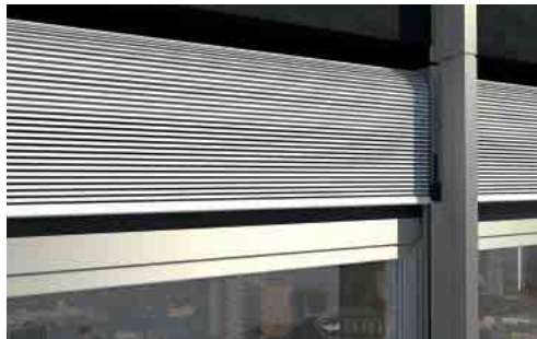
5. Montage des Sonnenschutzes 5. Installation of solar shading
