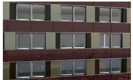
8. Die modernisierte Fassade 8. The modernised façade
