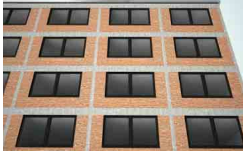
1. Die Bestandsfassade 1. The existing façade
