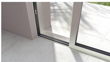
La soglia a filo pavimento elimina le discontinuità nel passaggio tra interno ed esterno.
