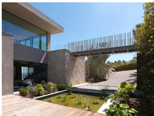
La passerella metallica sospesa ha un design leggero che collega la casa con parte del terreno. Pics Courtesy of Santoro Group srl
