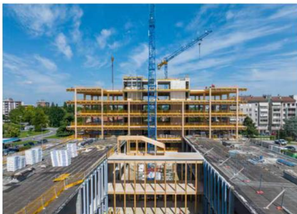
Fronte ovest del nuovo volume esterno ©LignoAlp
