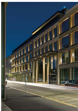
Le prestazioni dei serramenti hanno consentito il raggiungimento del livello Leed Gold
