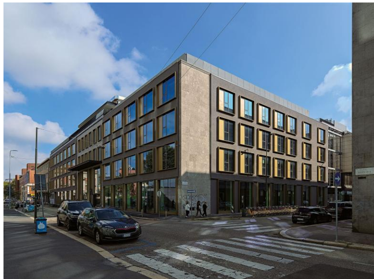
Edificio direzionale in Via Bernina 12 a Milano (foto Matteo Piazza)
