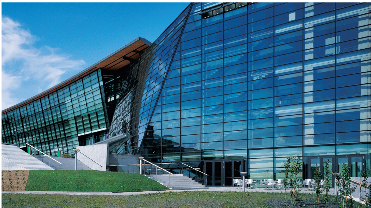
Foran glassfasaden på Telenor's hovedkontor på Fornebu er store områder tilgjengelige for publikum. Ved prosjektering er det viktig å vurdere både sannsynligheten for glassbrudd og konsekvenser av nedfall av glass. © Schüco International KG
