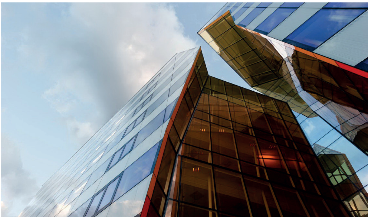
Et eksempel på glass med store krav til korrekt montering. Kontorbygget i Kista utenfor Stockholm har også fugete, «hengende» glass mekanisk sikret med punktfester. © Schüco International KG.
