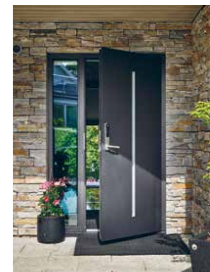
Ytterdörr med centrerad glasspalt och stående sidoglas för ljusinsläpp till hallen samt integrerat kodlås i handtaget. Blandningen av glas, sten, trä och aluminium visar en lekfullhet och orädsla för spännvidd.
