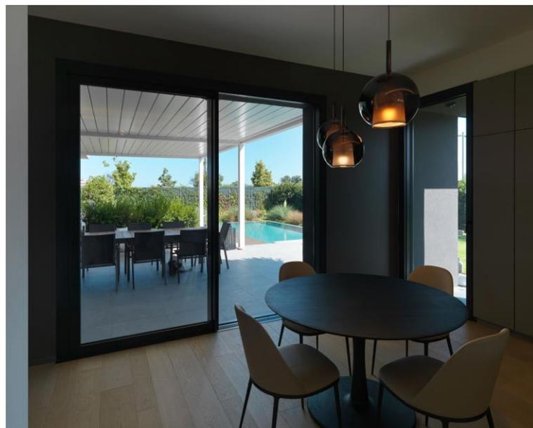
Per la realizzazione delle pareti vetrate delle zone living e camere da letto sono stati utilizzati **8 sistemi Schüco ASE 60**, soluzioni in alluminio “alzanti-scorrevoli” configurati, in questo caso, con anta apribile e specchiatura laterale fissa, così definiti perché prevedono prima un movimento in verticale di 8 mm per il distacco dei sistemi di tenuta e successivamente una traslazione orizzontale per la movimentazione.
