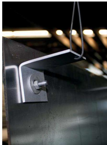
*Kontaktierung von Fixlängen durch Verschraubung / Pecobolzen*
