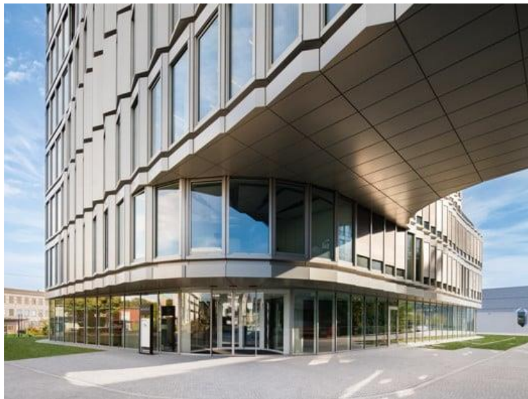
Schüco One: innovativo e caratteristico edificio che vede i sistemi in alluminio Schüco utilizzati per finestre a nastro, lucernari e facciate
