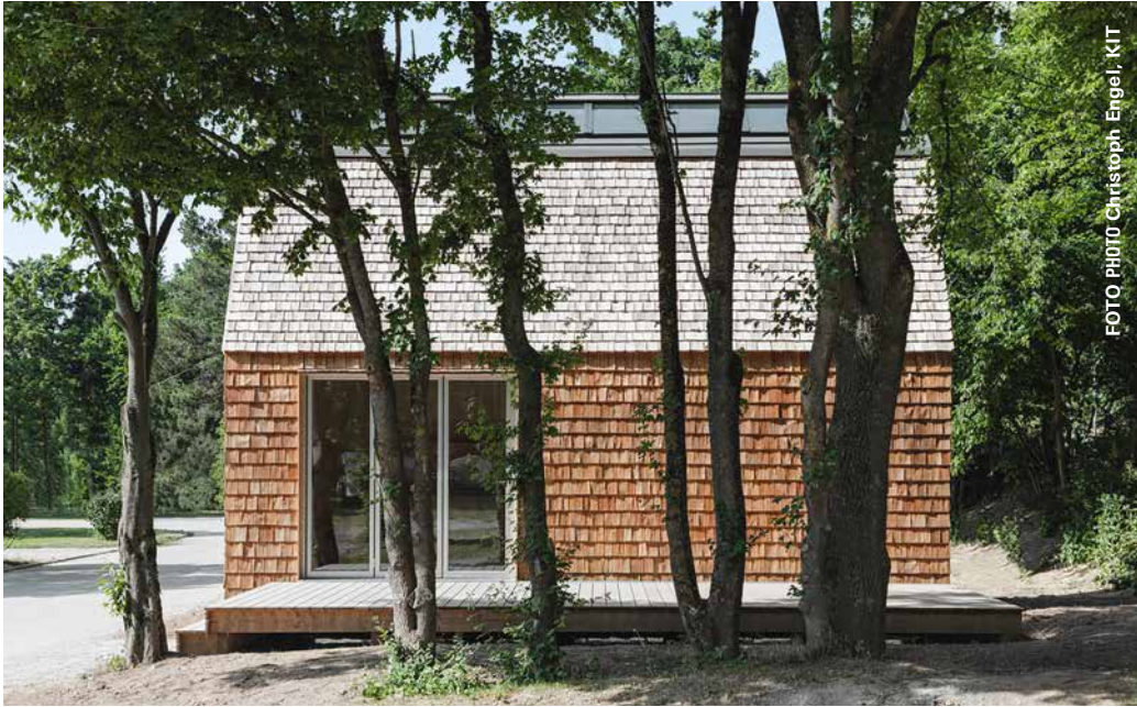
◀ Der Entwurf des REALLABOR TINY HOUSE wurde als sortenrein konstruiertes Design-Build-Projekt 1:1 auf dem Campingplatz Karlsruhe-Durlach realisiert.
