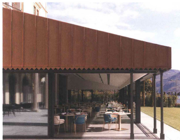
GRAND HOTEL VICTORIA, MENAGGIO L'intervento di ristrutturazione e ampliamento dell'edificio ottocentesco sulle rive del Lago di Como, firmato da Studio Pè Architettura & Design, ha incluso serramenti di alluminio custom-made messi a punto da Schüco per assicurare comfort acustico e termico. La vetrata del ristorante, dotata di un sistema scorrevole su binari con apertura ad angolo, sostiene la copertura di rame originale. • The renovation and extension of a late 19 th -century hotel on the shores of Lake Como, by Studio Pè Architettura & Design, involved the installation of Schüco's custom-made window-frames, which ensure acoustic and thermal comfort. The glass walls of the panoramic restaurant, equipped with a sliding track-mounted corner opening system, support the original copper roof. schueco.it
