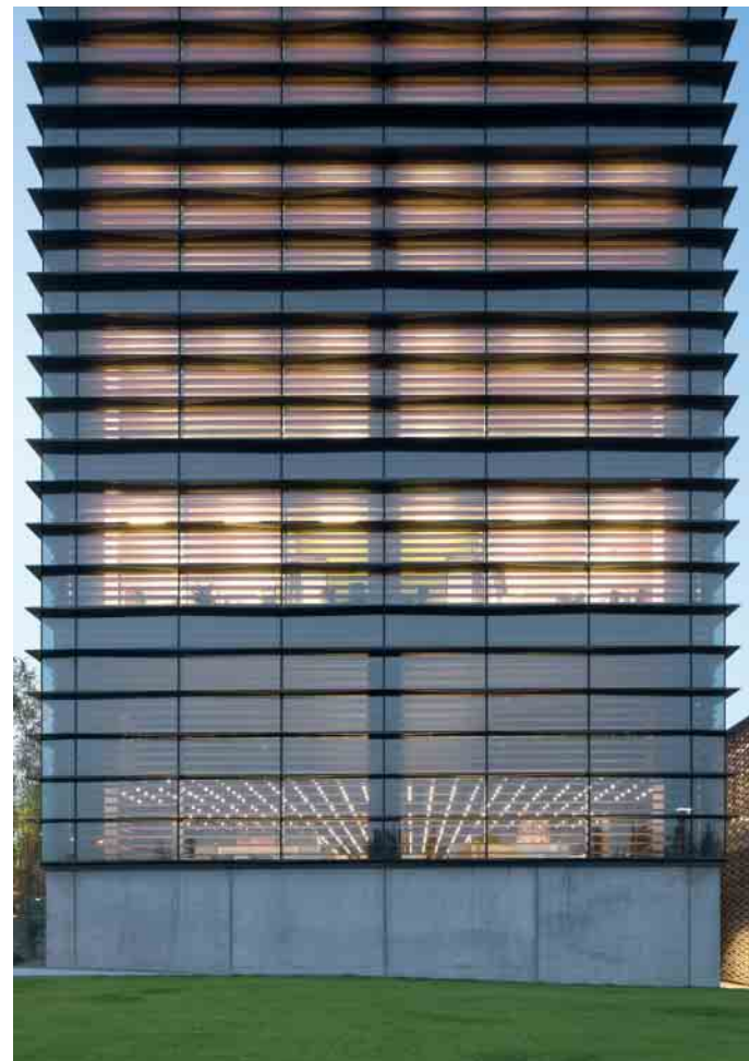
▼ Bei geöffneten Lamellen zeigt sich das Innere des Gebäudes. ▼ Opening the louvre blades showcases the interior of the building.
