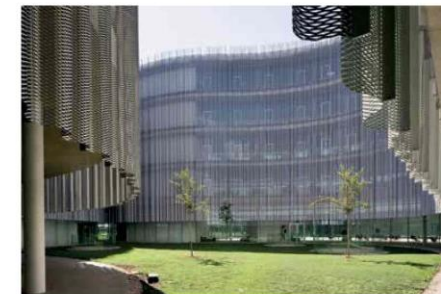
La prova in galleria del vento ha tenuto conto anche della presenza di una seconda pelle in lamiera forata (Foto credits: Philippe Ruault Photograph)
