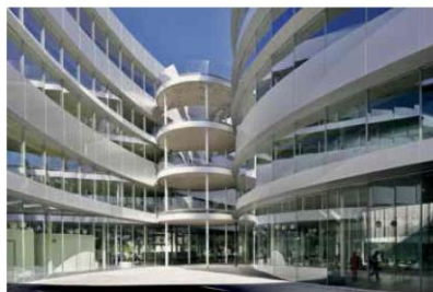
Per permettere l'alternanza di vetrate curve e dritte e di angoli positivi e negativi, che determinano il ritmo delle facciate, i sistemi in alluminio Schüco sono stati customizzati. (Foto credits: Philippe Ruault Photograph)
