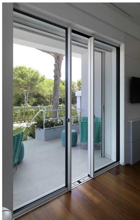
Nella camera da letto padronale le ante dello scorrevole Schüco ASE 67 PD scompaiono all'interno delle pareti (ph. ©Daniele Domenicali).
