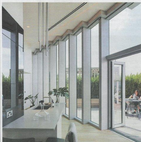
▲ Sole sotto controllo Le facciate del Manhattan Loft Gardens di Londra sono realizzate da Agc Glass Europe con vetro a controllo solare ipasol light grey 60/33: d'estate non surriscalda gli interni e d'inverno non disperde il calore
