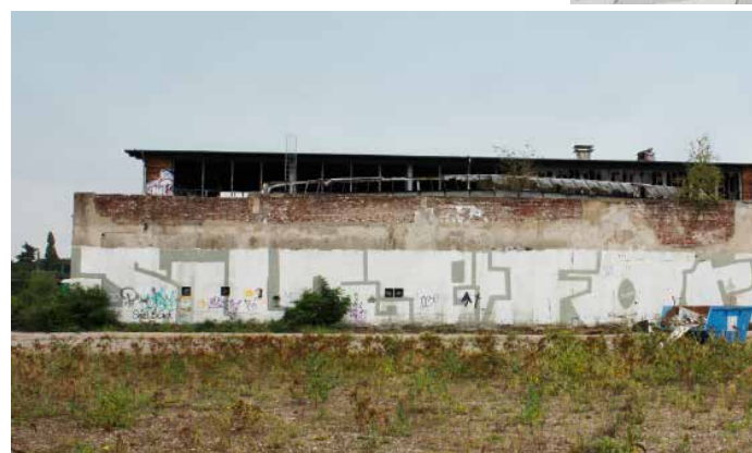
Vor Beginn der Sanierung war der Zustand der ehemaligen Großviehmarkthalle katastrophal.
