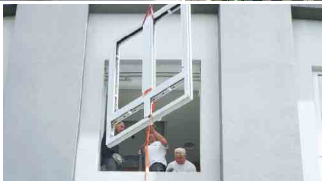
Der Einbau der neuen Fenster erfolgte von außen, sodass die Räume auch während der Baumaßnahme genutzt werden konnten.
