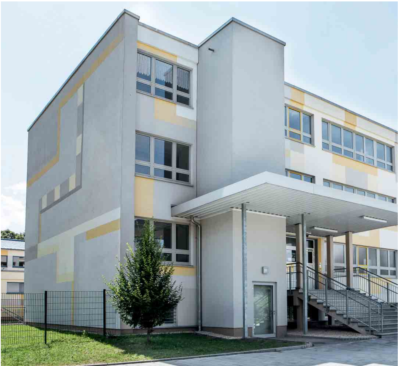
Die Grundschule Am Rosarium mit dem neu angebauten Aufzugturm und der modernisierten Fassade
