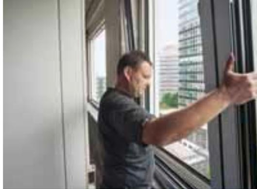
Das neue Fenster wird in den alten Blendrahmen montiert.
