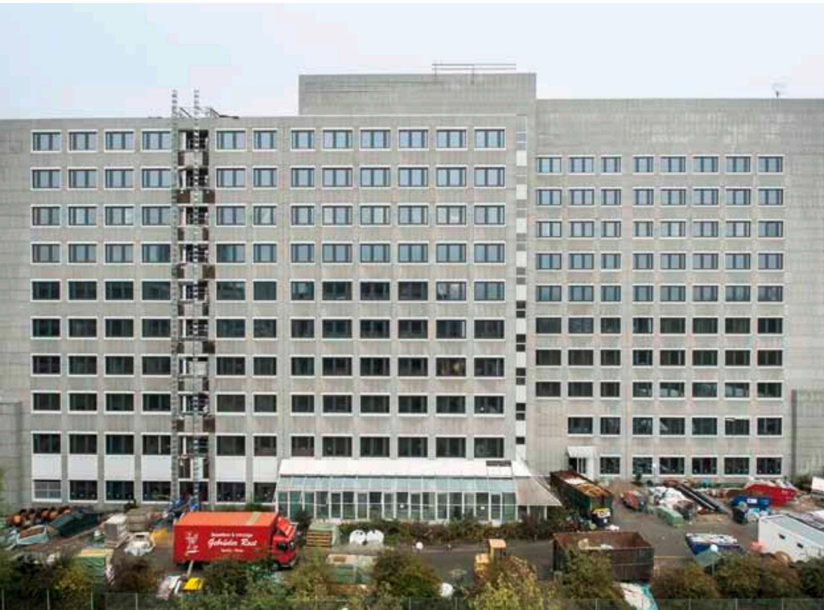
Bauvorhaben in Frankfurt-Niederrad: Schüco Partner Anders Metallbau demonitierte im neunstöckigen Büroriegel rund 463 Fenster und setzte das hochwärmegeämmte System Schüco AWS 75.SI ein. Die alten Fensterprofile wurden nach der Demontage recycelt und zu neuen Produkten verarbeitet.
