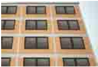
1. Der Ausgangspunkt: Eine Stahlbeton-Konstruktion aus den 1970er-Jahren, wie sie noch häufig zu finden ist.
