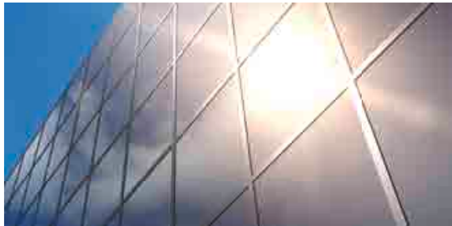
Schüco ProSol TF lässt sich als Verbundglas in Kaltfassaden einsetzen und verwandelt damit kostengünstig opake Flächen in Solarkraftwerke.
