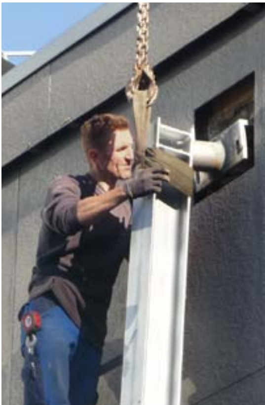
Die Module der Anlehnfassade Schüco FSE 3000 sind in hohem Maße vorgefertigt (oben) und lassen sich mit geringem Aufwand an der Fassade befestigen (unten).
