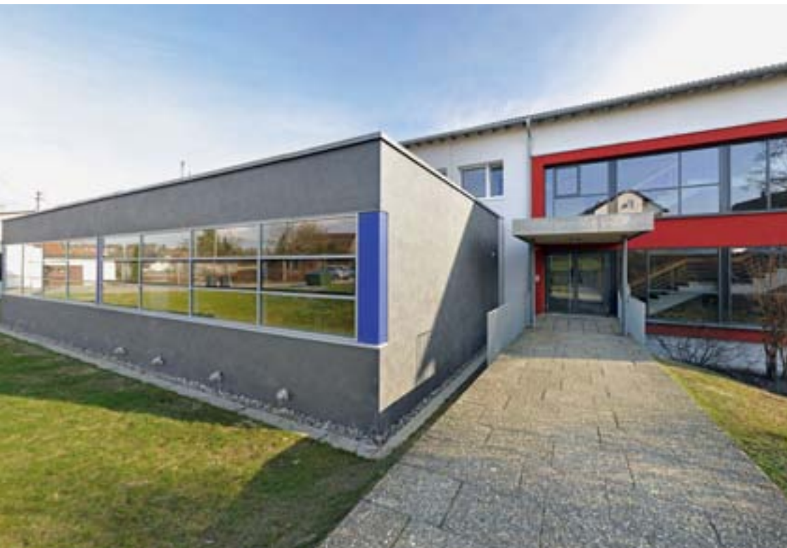
Die Grund- und Hauptschule mit Werkrealschule in Schopfloch wurde mit Mitteln aus dem zweiten staatlichen und dem Schüco Energy 2 Konjunkturpaket saniert.
