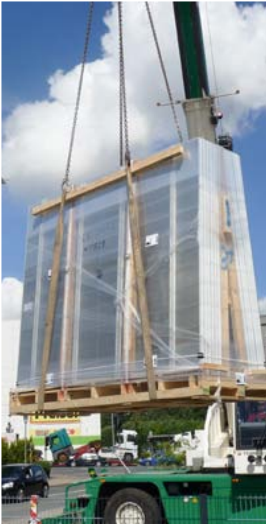
Die Module der Anlehnfassade Schüco FSE 3000 sind in hohem Maße vorgefertigt (oben) und lassen sich mit geringem Aufwand an der Fassade befestigen (unten).
