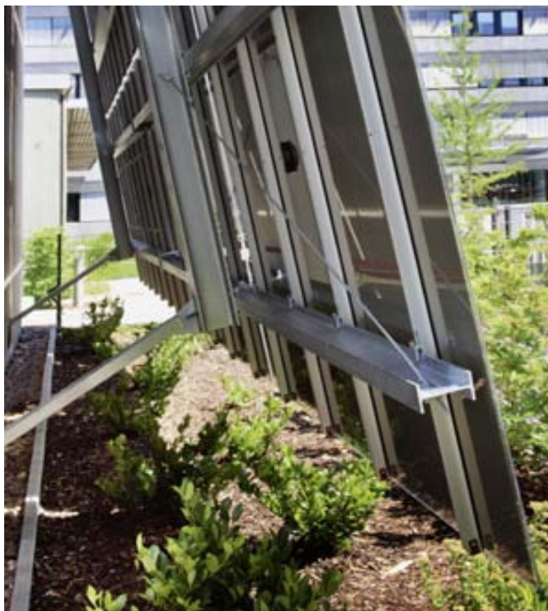
Unterer Anschlusspunkt der Anlehnfassade
