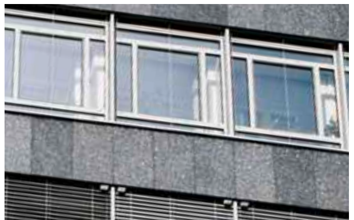
28 Referenz: Hans-Böckler-Haus benötigt 45 % weniger Energie
