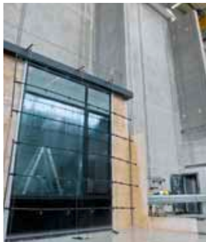
Der neue Prüfstand bietet den Monteuren viel Platz und Komfort. Sie bauten das Element in sehr kurzer Zeit auf.
