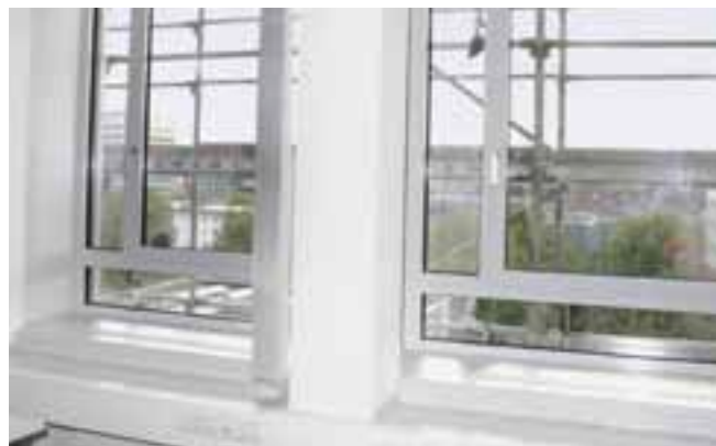
In sehr kurzer Zeit brachten die Monteure die Innenverkleidung an. Gebäudenutzer verließen für höchstens zwei Tage ihre Büros.
