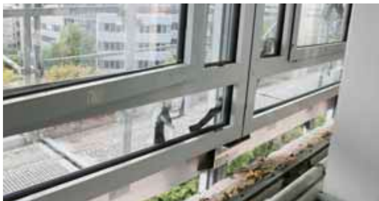
Erst nachdem die neue Außenhaut stand, entfernten die Mitarbeiter von Anders Metallbau stockwerksweise die alten Fensterelemente.
