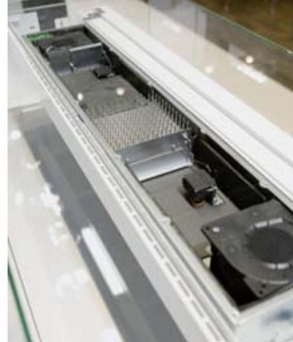
Schüco VentoTherm sorgt für Frischluft bei geschlossenem Fenster; durch die Wärmerückgewinnung bleibt die Heizenergie im Raum.
