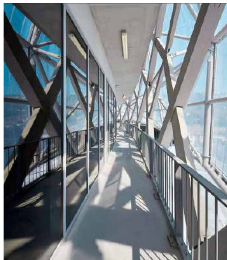
Die transluzente Gebäudehülle und das offene Tragwerk erlauben gute Ausblicke ins und aus dem Stadion.
