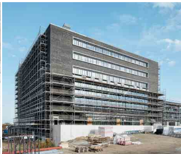
Die Fassade ist fertig, nach und nach werden die Gerüste abmontiert.
