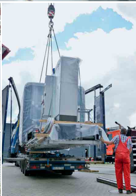
Um diese Maschine vom Truck zu heben, wird ein starker Kran eingesetzt.
