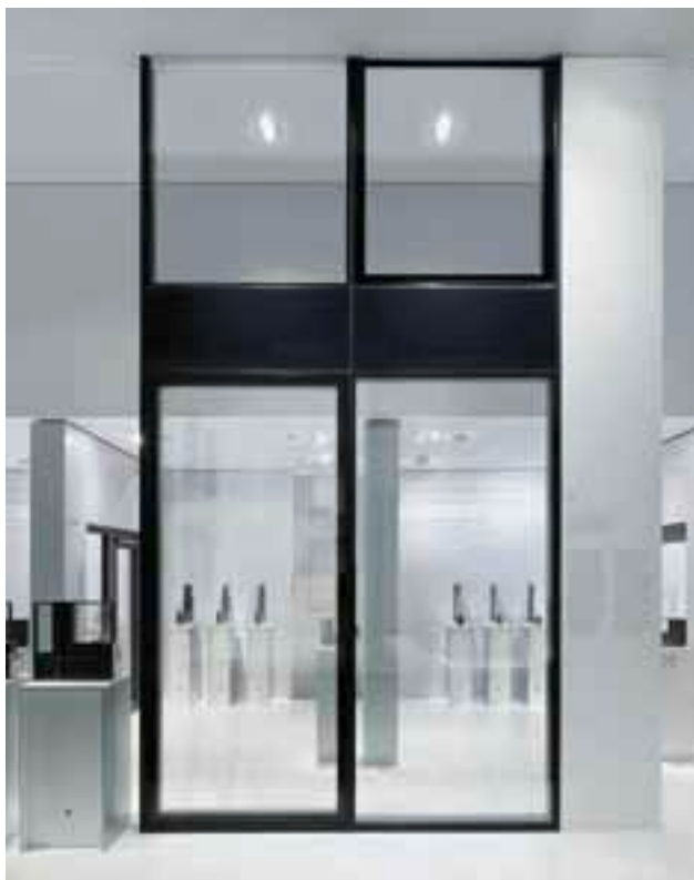
Raumhohe Fassadenelemente zeigen die eleganten Proportionen der Profile.
