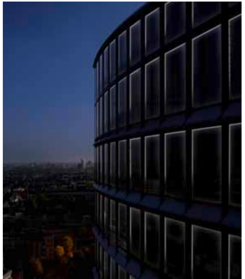
Vollintegriert ist bei der Fassade Schüco FW 50+.SI Green die LED-Beleuchtung Schüco LightSkin.
