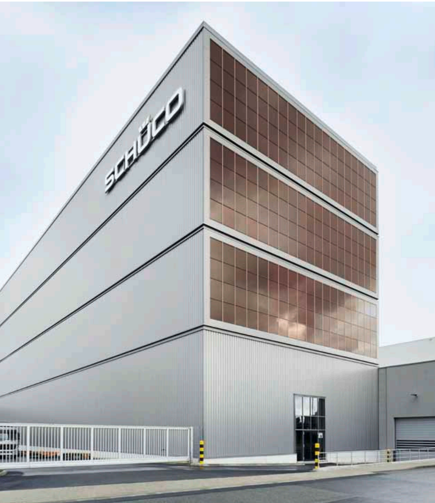
Eines der beiden Schüco Hochregallager mit fassadenintegrierten Photovoltaikmodulen
