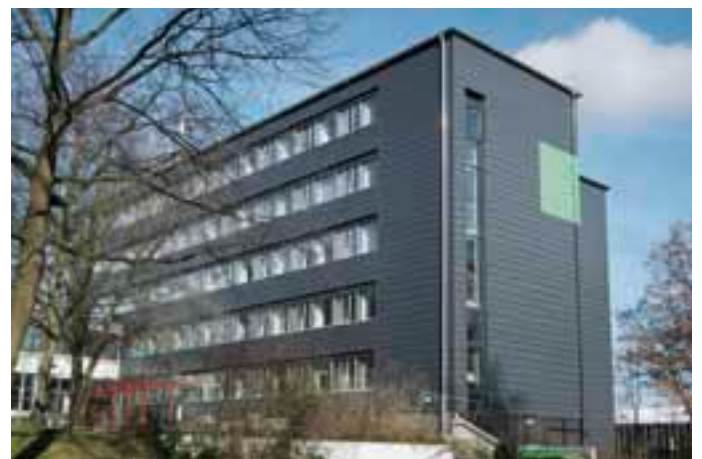
32 Referenz: Erster Verwaltungsbau im Passivhausstandard saniert
