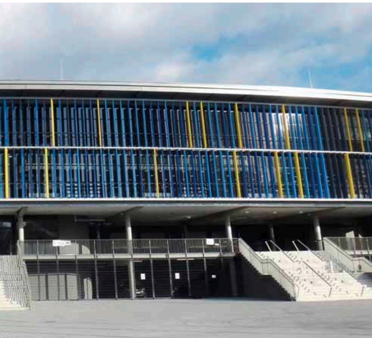
Für die zweigeschossige Fassade des Eintrachtstadions fiel die Wahl auf Schüco Jansen VISS Ixtra, das mit schmalen Profilen große Spannweiten überbrückt.
