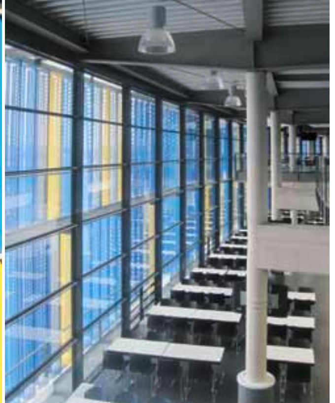
Die Aluminiumlamellen verleihen der Fassade ein unverwechselbares Gesicht und bieten effektiven Sonnenschutz.
