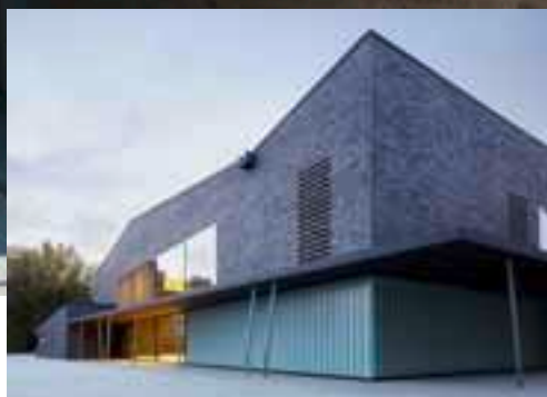
Gegensätzliche Raumkonzepte in Bergedorf geschickt kombiniert: Neubau einer Dreifeldhalle mit Kulturteil
