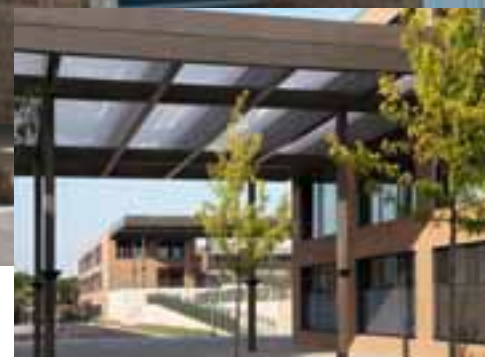
Ein Musterbeispiel in Sachen Gebäudeautomation: die Europaschule II in Luxemburg
