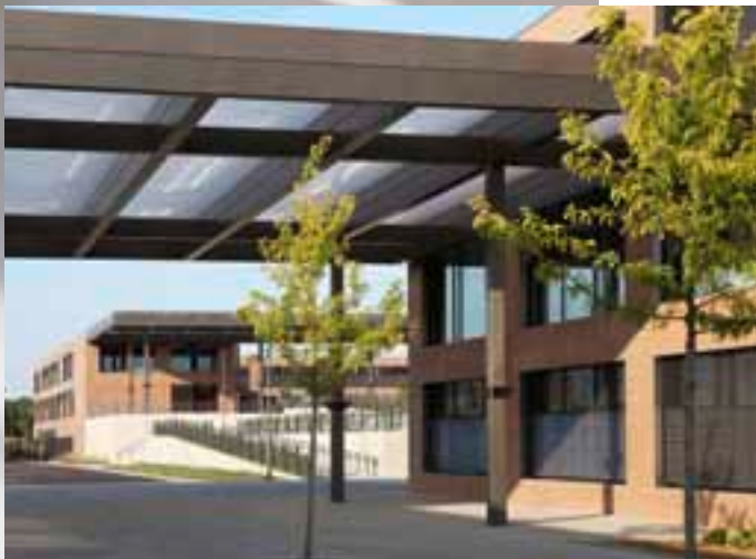
Die zahlreichen Vordächer sind mit eingespannten aufblasbaren Wolkenmembranen für den UV- und Regenschutz ausgestattet.
