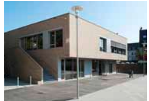
Klare Linien charakterisieren den Erweiterungsbau. Die Treppe führt hoch in die Mensa.
