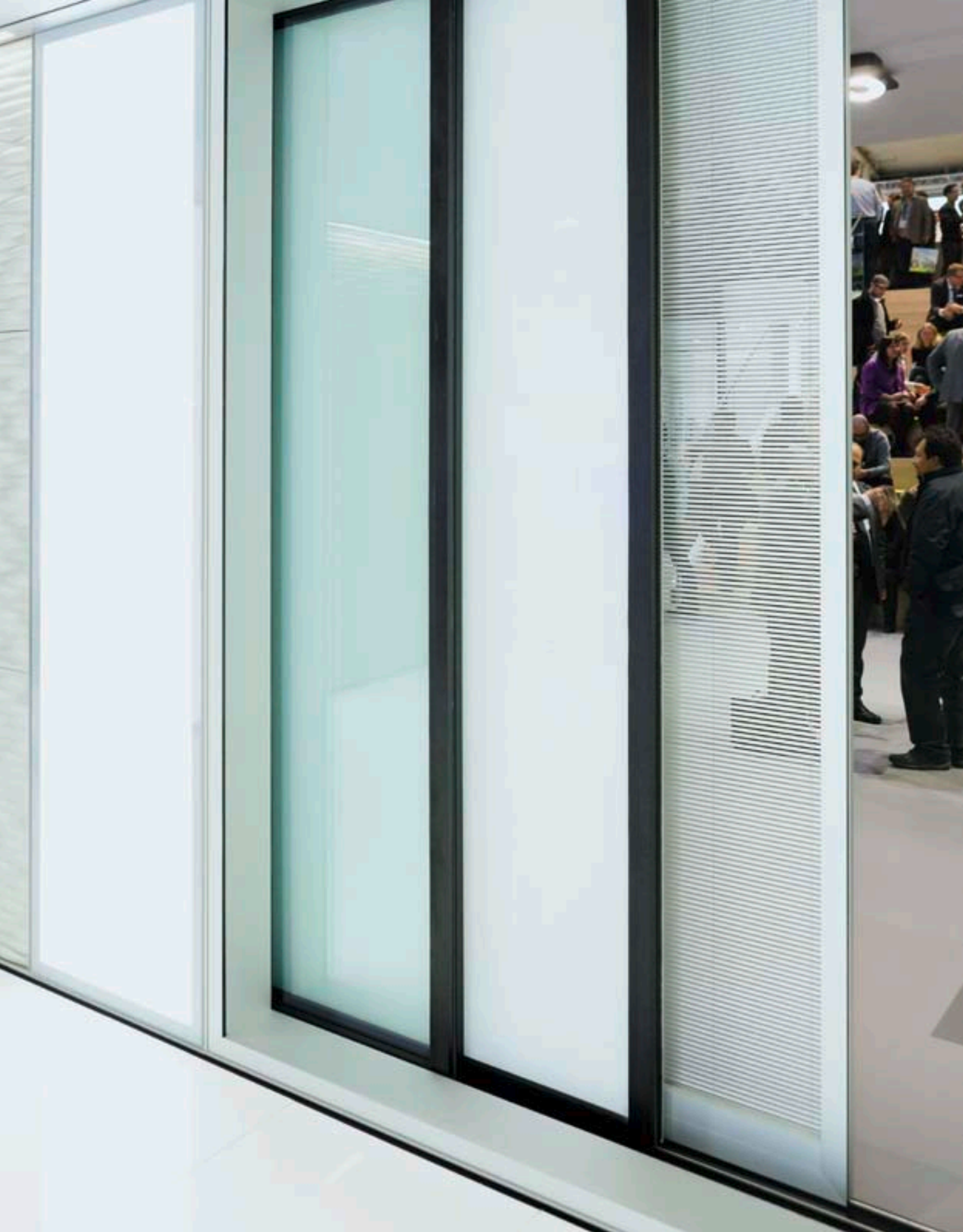
Innenansicht: Die thermoaktiven Wände des Energy 3 Buildings speichern mittels Phase Change Materials Wärme und geben sie bei Bedarf wieder ab (links). Die Innenverkleidung ist variabel gestaltbar. Rechts sieht man die einzelnen Layer (Glas-Layer, Dämm-Layer, Sonnenschutz-Layer).
