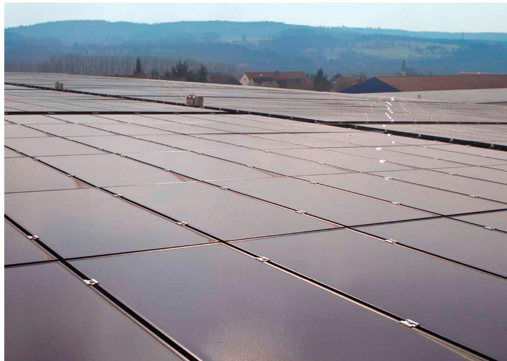
Schüco SPV 80 TF-Anlage der Superlative: Auf 3.430 m<sup>2</sup> gewinnt das System Energie und produziert im Jahr etwa 330.000 kWh Strom.
