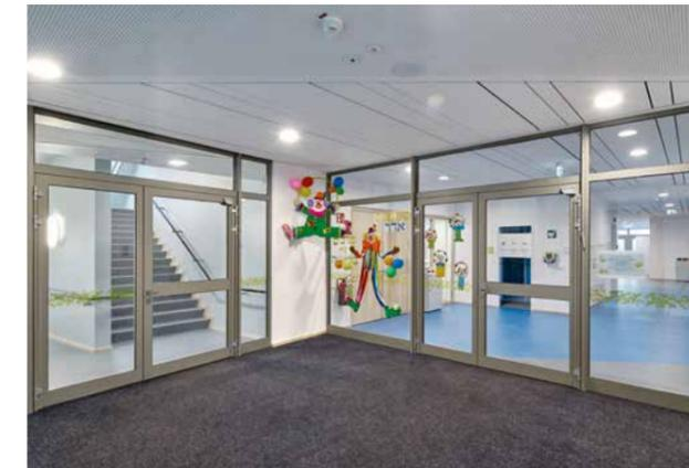
▲ Die SÄLZER Sicherheitsstahlrohr-Rahmentüren in der entsprechenden Widerstandsklasse führen in die Klassenzimmer oder das Treppenhaus.
