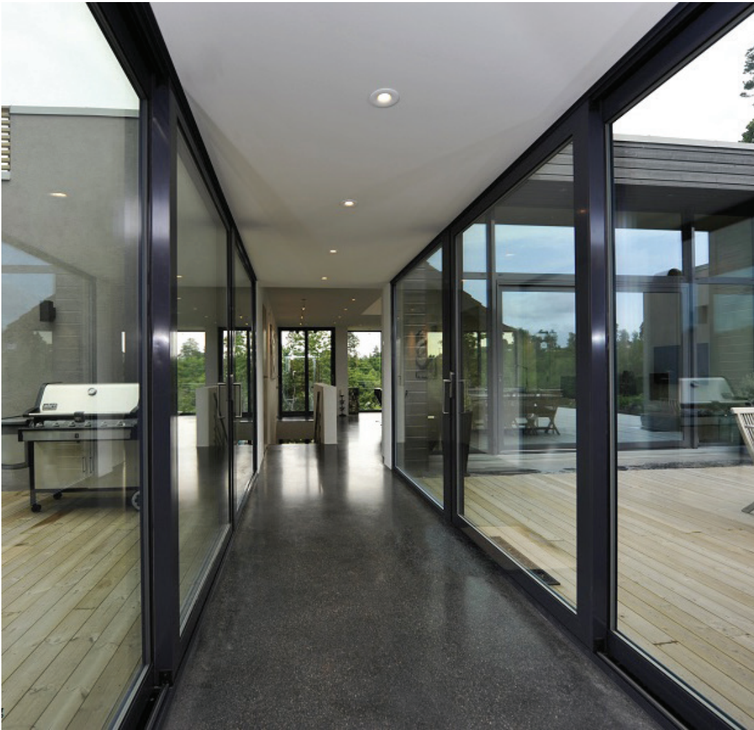
Glasskorridor forbinder gammelt og nytt og består av store skyvedører og glassfelt.
