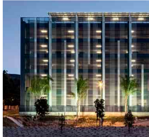
Semitransparente Sichtschutzfassade für das FBI-Parkhaus, San Diego/USA.
