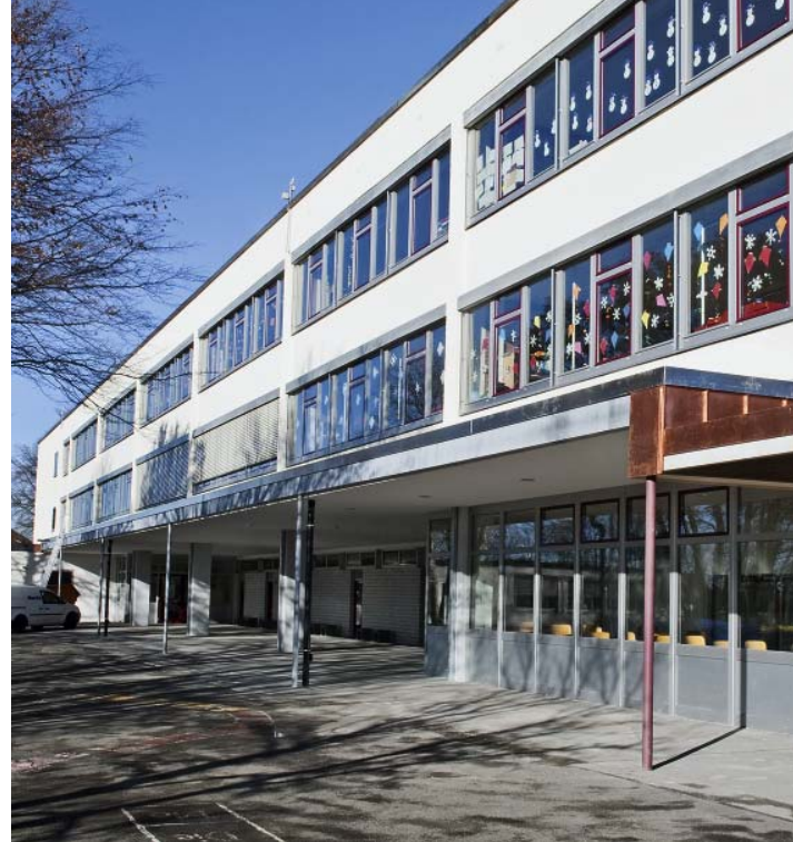
Modern präsentiert sich die neue Fassade der Schillerschule. Schüco AWS 75.SI trägt maßgeblich zur Energieeinsparung bei.
