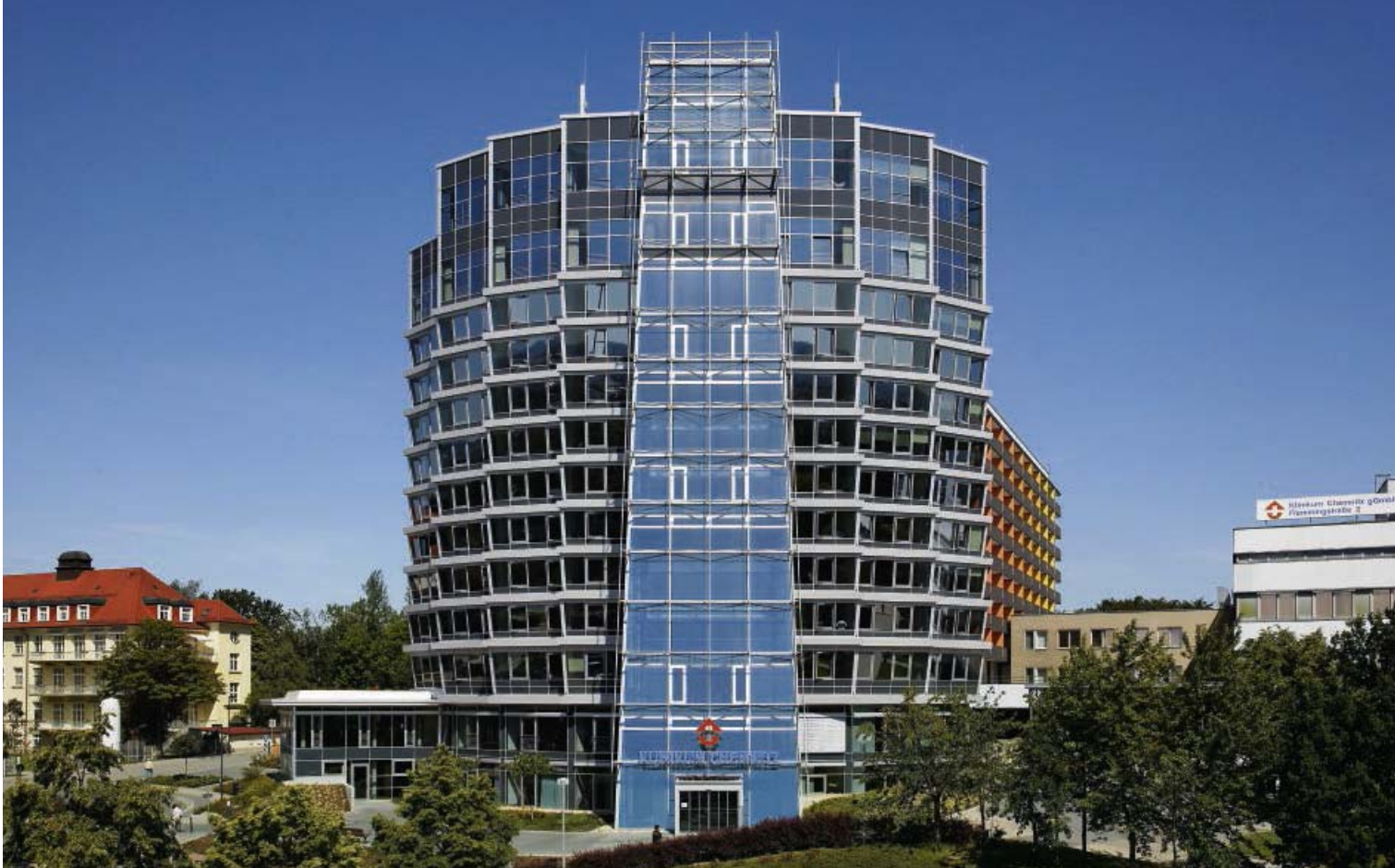
Mit den Schüco Systemen FW 50+ und AWS 70.HI leicht zu realisieren: eine transparent anmutende Fassade wie hier beim Klinikum Chemnitz
