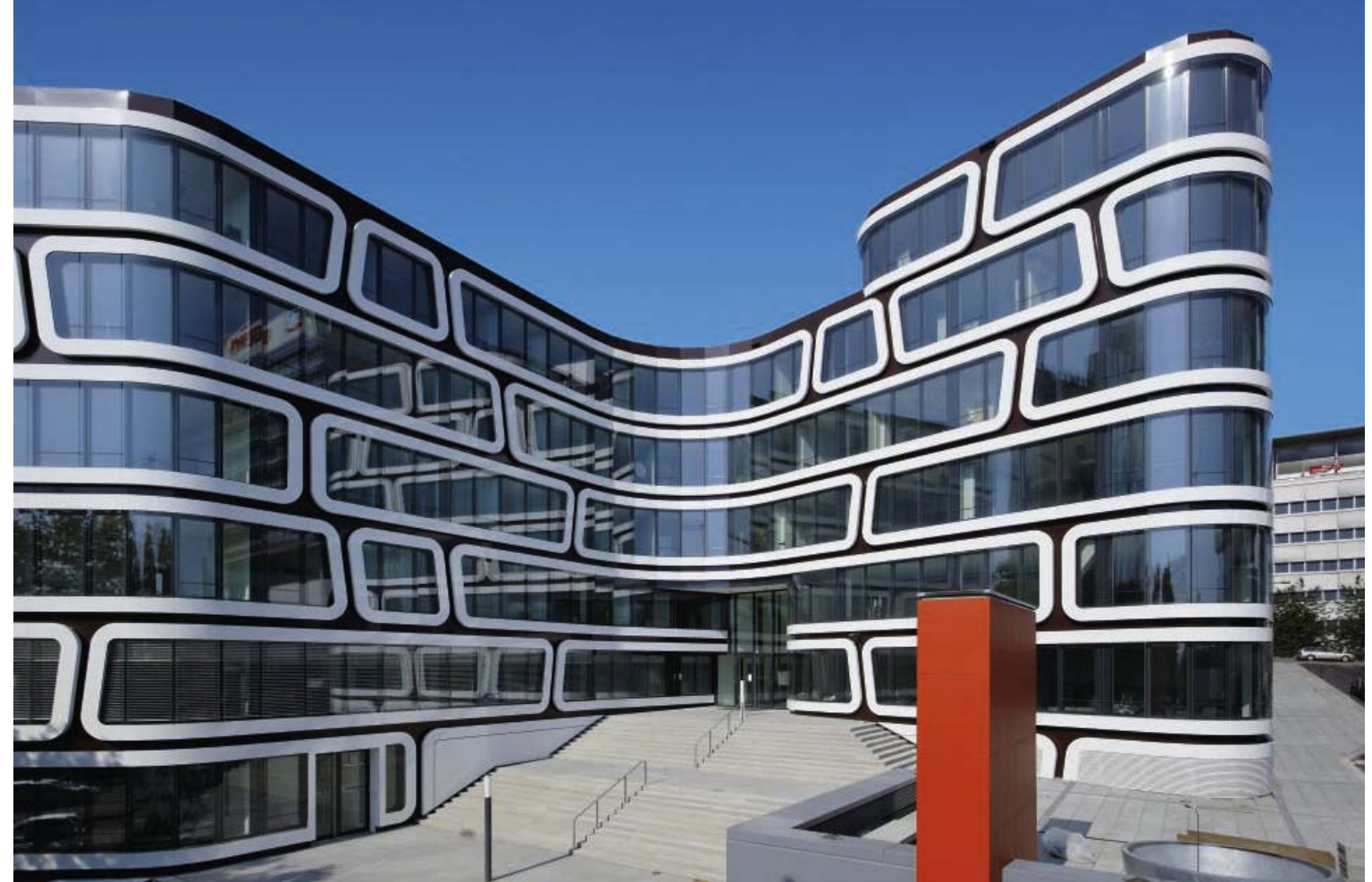
Das Z-UP setzt in Stuttgart Mitte einen neuen architektonischen Akzent. Und Schüco Partner Rupert App GmbH & Co., der die Fassade fertigte, hat jetzt ein spektakuläres Referenzobjekt.
