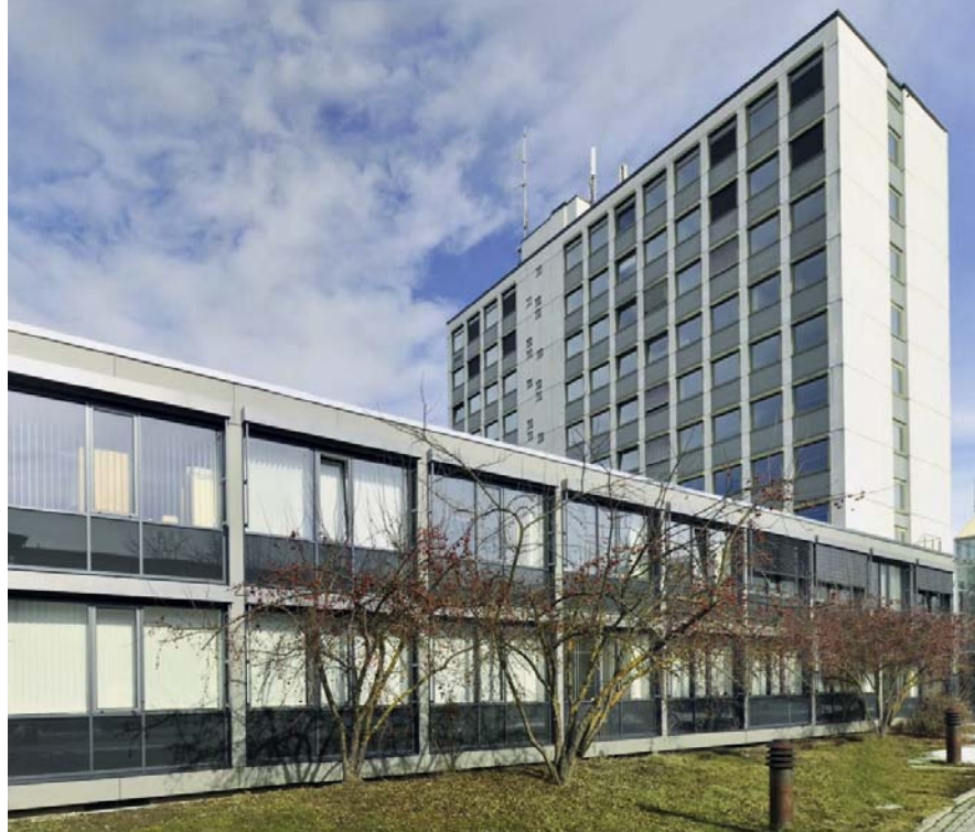
Der Querriegel des Landratsamtes im neuen Gewand: Die Schwerpunkte der Sanierung lagen auf Energieeinsparung und Nachhaltigkeit.
