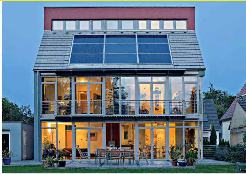
Einfamilienhaus mit Solaranlage zur Wärme- und Stromgewinnung
