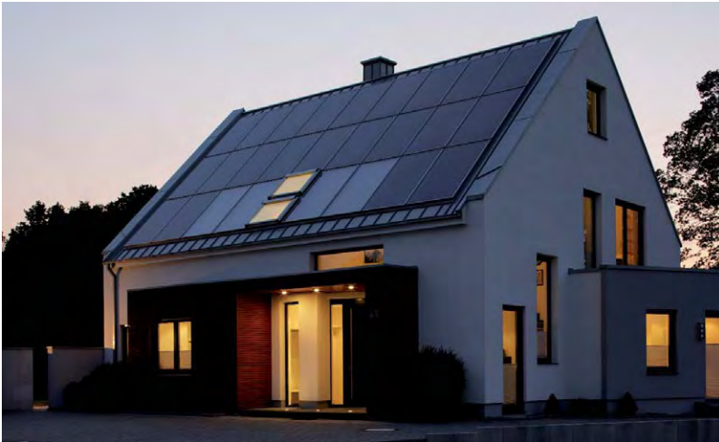
Eine Solarthermieanlage mit vier SchücoSol HP Tieftemperaturkollektoren übernimmt in Verbindung mit einer Wärmepumpe die gesamte Gebäudeheizung
