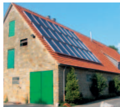
Landwirtschaftlicher Betrieb mit Aufdachmontage
