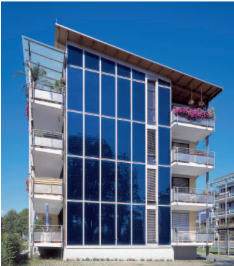
Mehrfamilienhaus mit Fassadenmontage
