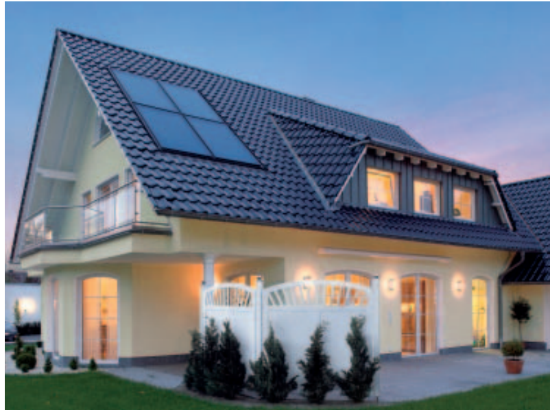
Solarthermieanlage zur Heizungsunterstützung
