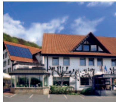
Hotel mit Indachmontage
