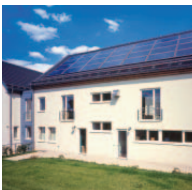
Mehrfamilienhaus mit Photovoltaikanlage
