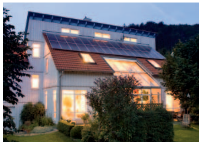
Photovoltaikanlage mit Netzeinspeisung
