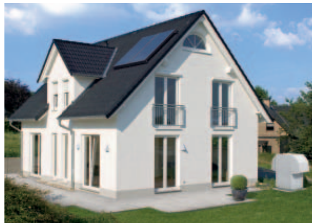
Luft/Wasser-Wärmepumpe mit Solarthermieanlage
