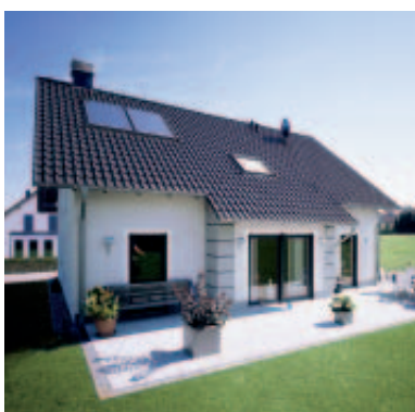
Einfamilienhaus mit Solarthermieanlage
