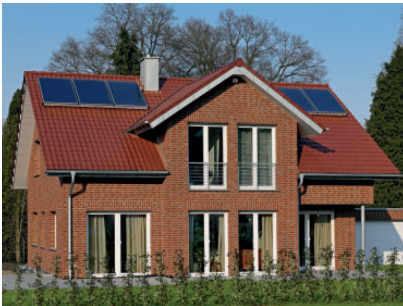
Eine Solarthermieanlage mit sechs Kollektoren übernimmt in Verbindung mit einer Schüco Wärmepumpe die gesamte Gebäudeheizung
