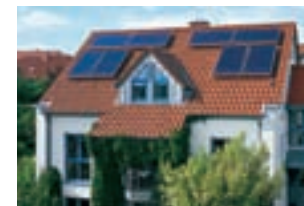
Montaggio sopra tetto
