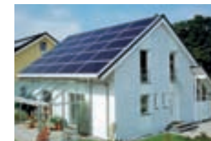
Montaggio a tutto tetto
