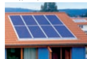
Montaggio integrato nel tetto
