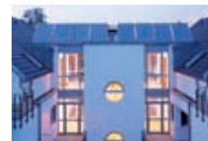
Montaggio tetto piano
